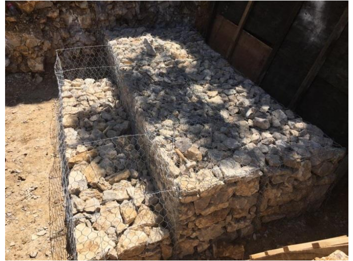
Suministro y colocación de malla y piedra para la formación de la base del muro gavión.
