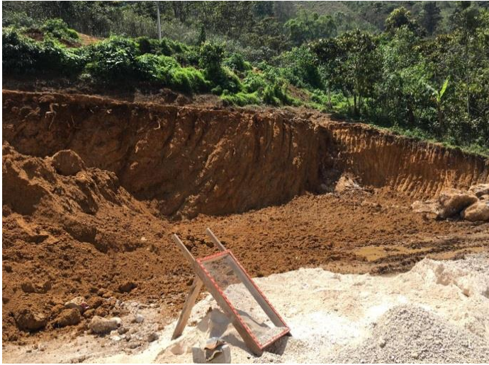
Corte y excavación para la construcción del muro gavión.
