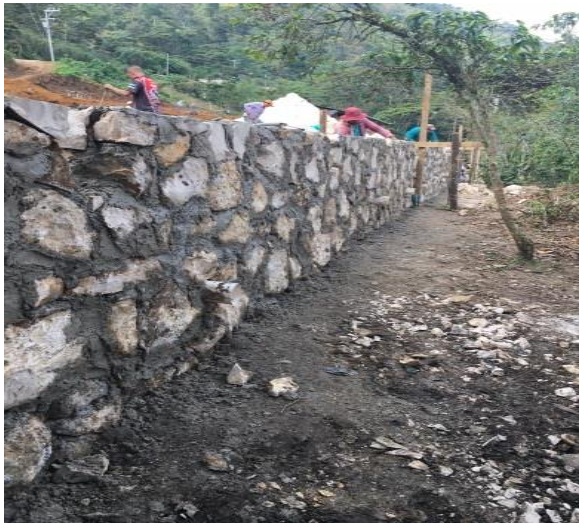
Construcción de muro de mampostería para la formación del terraplén en donde se construyen los edificios.
